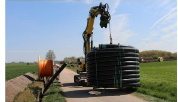
Grabenfräse + Verlegung der Wärmerohre
