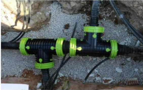
T-Stück im offenen Graben
