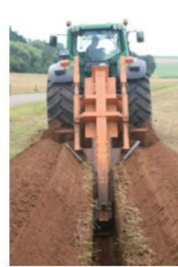
Grabenfräse + Verlegung der Wärmerohre
