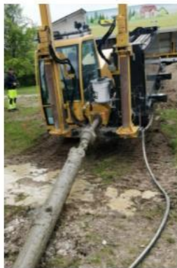
Grabenlose Verlegung im günstigen Spülbohrverfahren
